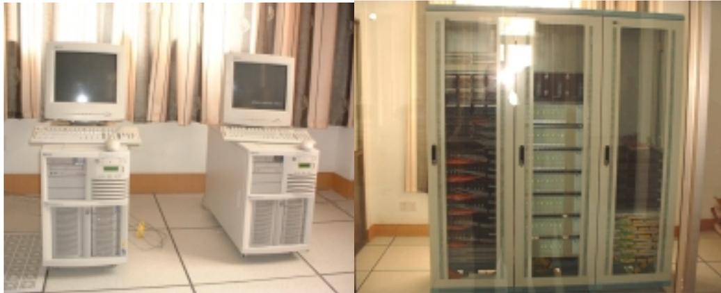
本系统采用光缆及双绞线星型拓扑结构方式，以小区管理中心为计算机网络中心，构建住宅小区内部网，并可以通过路由器或其它网络设备接入 ISDN，xDSL，DDN 接入，从而实现高速 INTERNET 互联。
